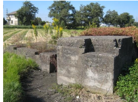
写真7 巨大なコンクリの台 地元では「飛行機の洗濯場」と呼ばれた。
