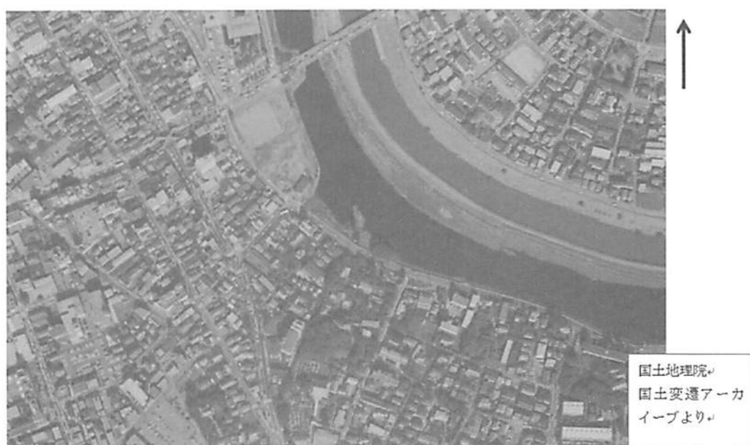
図-2-2 越谷 航空写真 平成元年（1989）10月21日
