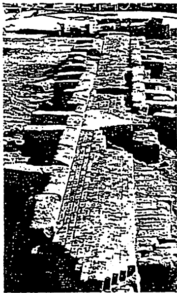
▲灰磚場 明治14年の平面図には存在するが、開業時には記載がなく、いつの時点で設置されたか明確ではない。レンガ製の引き込み部分は比較的良好に残っており、規模は長さ約19m、幅2m程である。(北東より)
