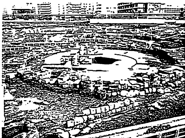
▲機関車庫 扇形の機関車庫と対になって検出されたもので、土台のみが残っていた。直径約13m、凝灰岩製の切石で構築されており、底面にはコンクリートが打たれている。国産のセメント製造は明治8年が発切であるから、明治5年に完成したこの施設には輸入セメントが使用されたのだろう。(南西より)
