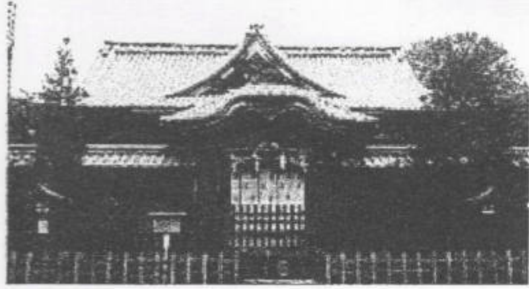
現在修復中の上野東照宮
