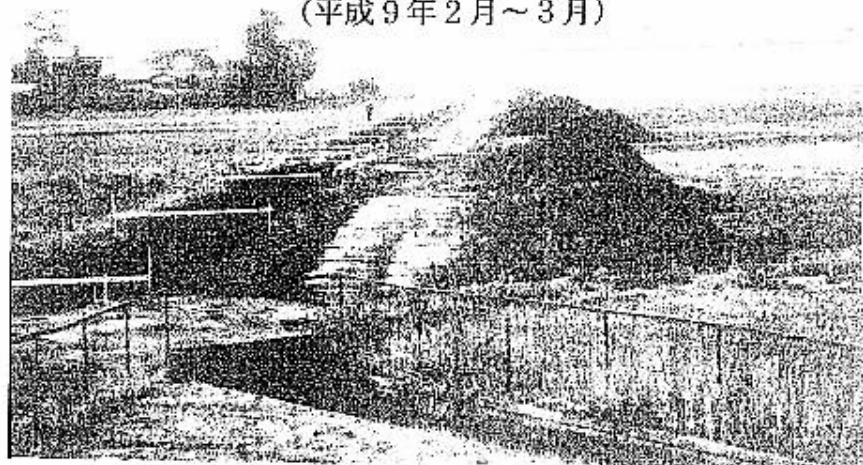
増林の通称「土手岸」での排水路工事 (平成9年2月～3月)
