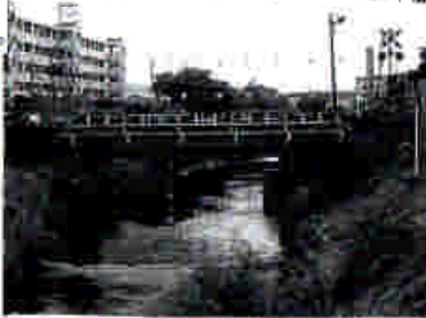
新方川に架かる鉄橋
