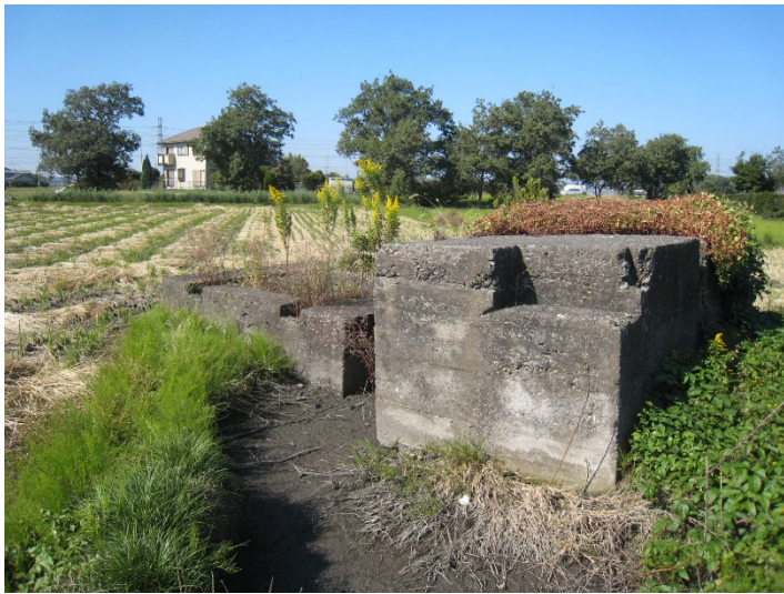
巨大なコンクリート台跡
