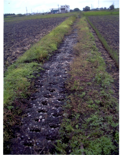
滑走路の西側の暗渠跡
