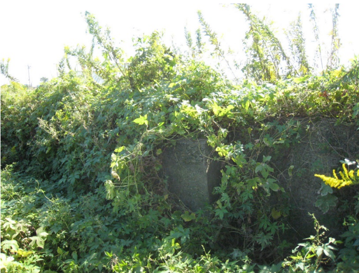
格納庫跡（床下南側の外壁）
