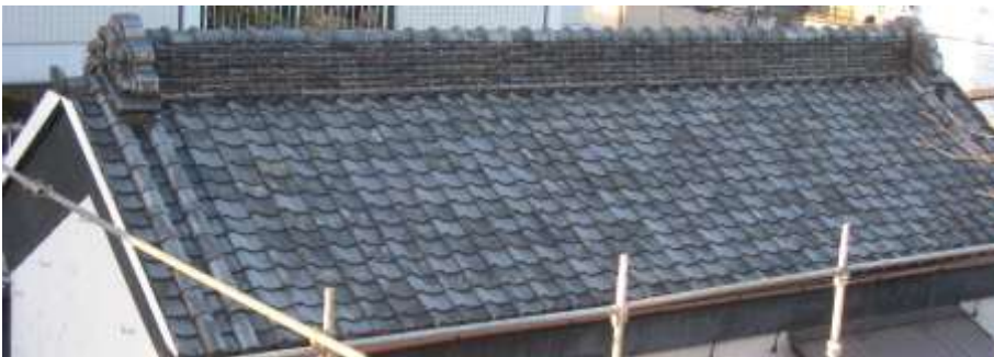
染谷家土蔵の屋根（南側の越谷産業会館3階より撮影）
