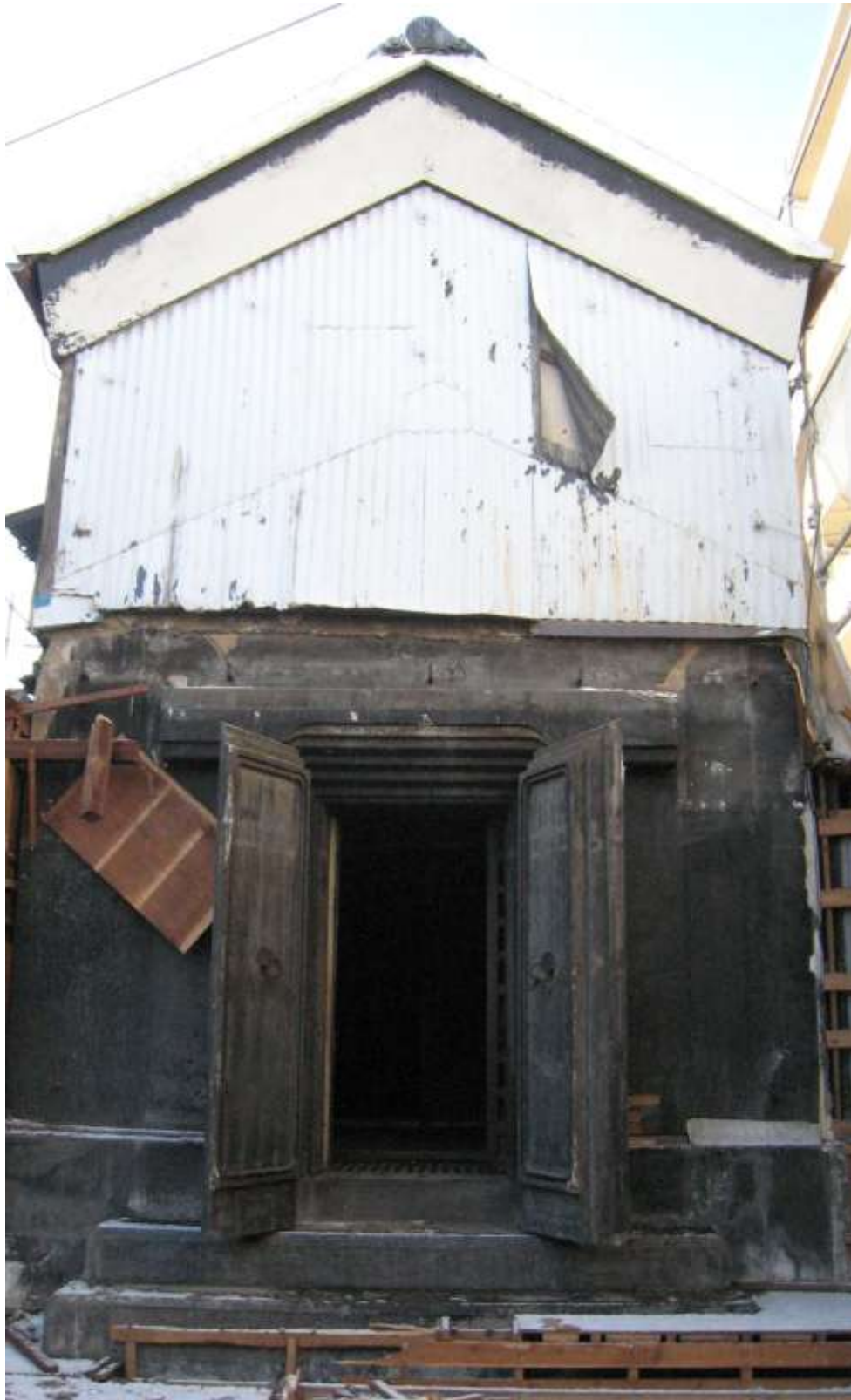
平成23年1月16日に日光街道側から正面を写す。2日後に解体する。
